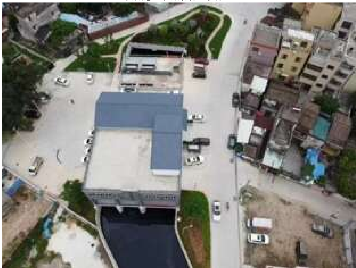
本项目建设完成后场地航拍图，2022年6月
