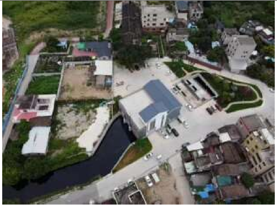
附件 8：重要水土保持单位工程验收照片
