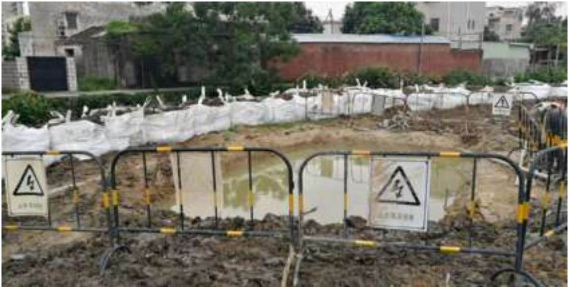
施工期间临时土袋拦挡
