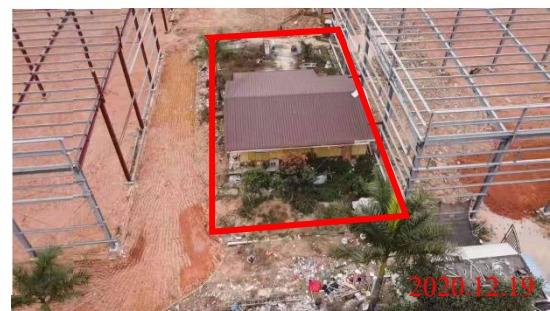
施工营地现状
